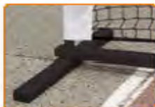
Detalle del apoyo.
